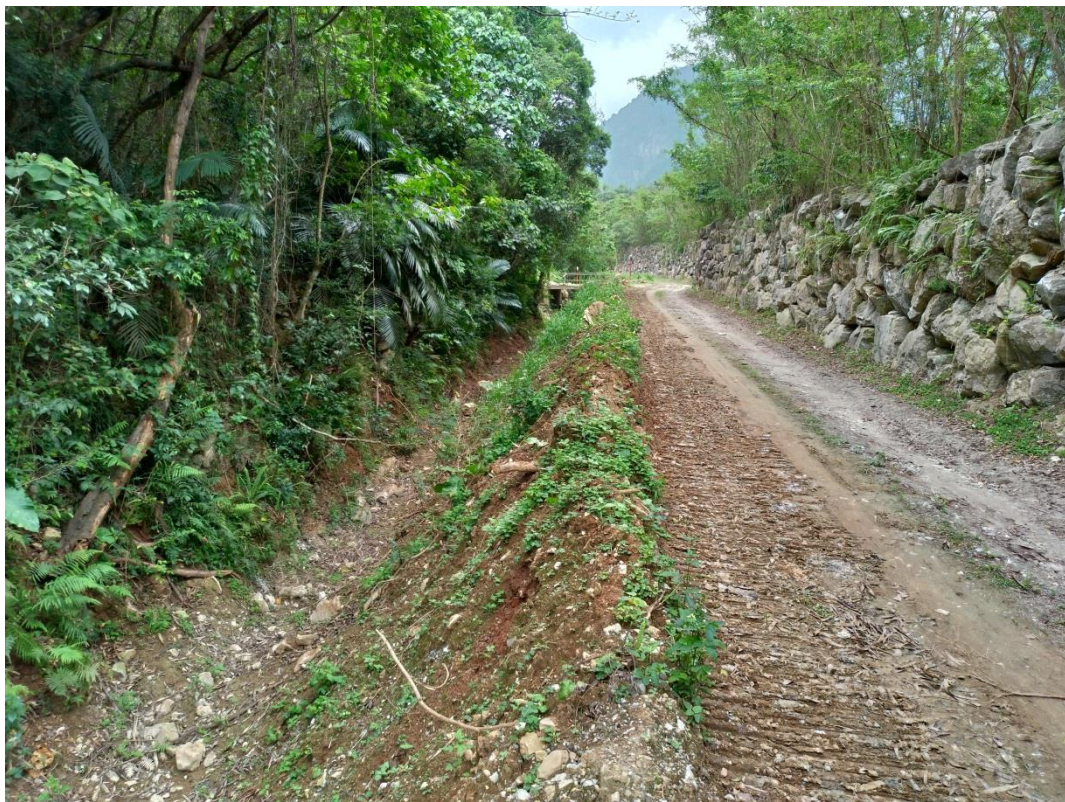
圖四、沉砂池聯外道路、攔石牆、排水溝狀況良好
