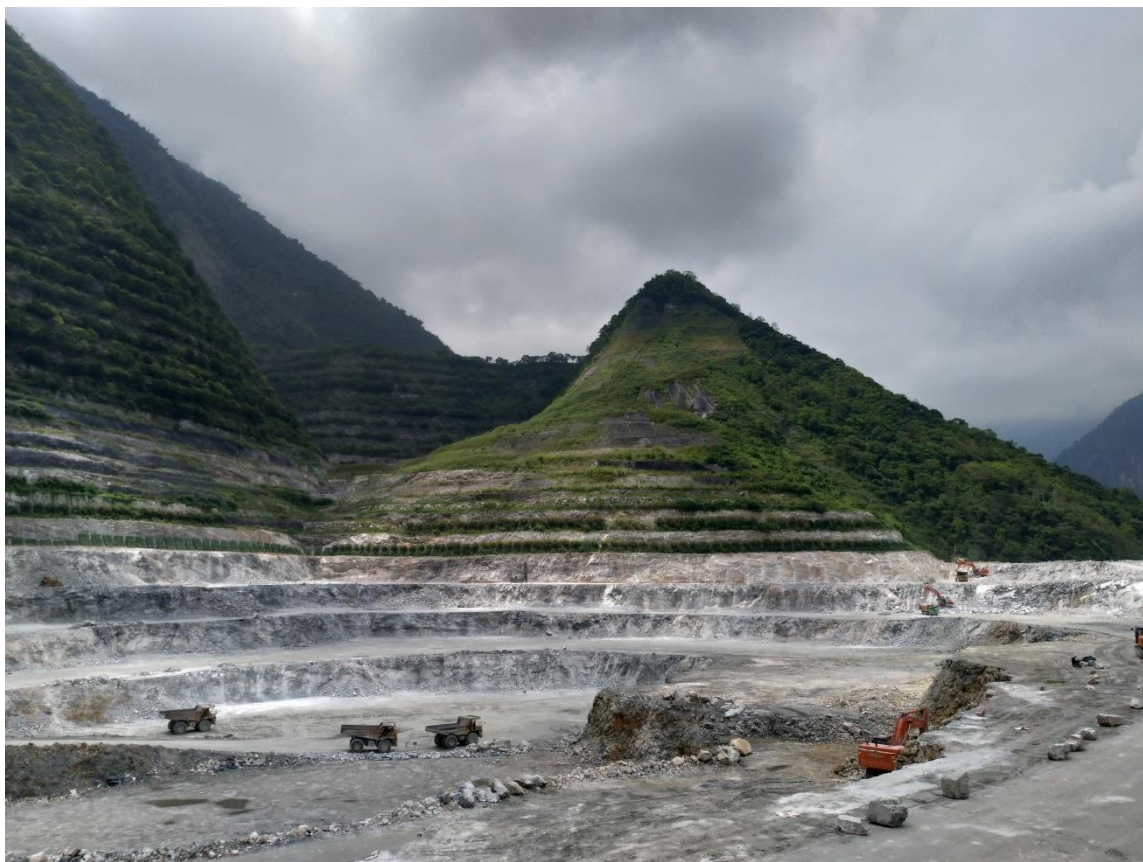
圖二、北側邊坡目視完整，植被保持良好
